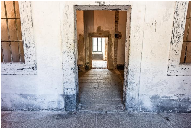
Türschwelle Sonderausstellung im OG - Soglia della porta della mostra temporanea al piano superiore
