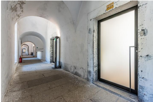
Türschwelle im OG der Verwaltung - Soglia della porta al piano superiore dell'edificio amministrativo
